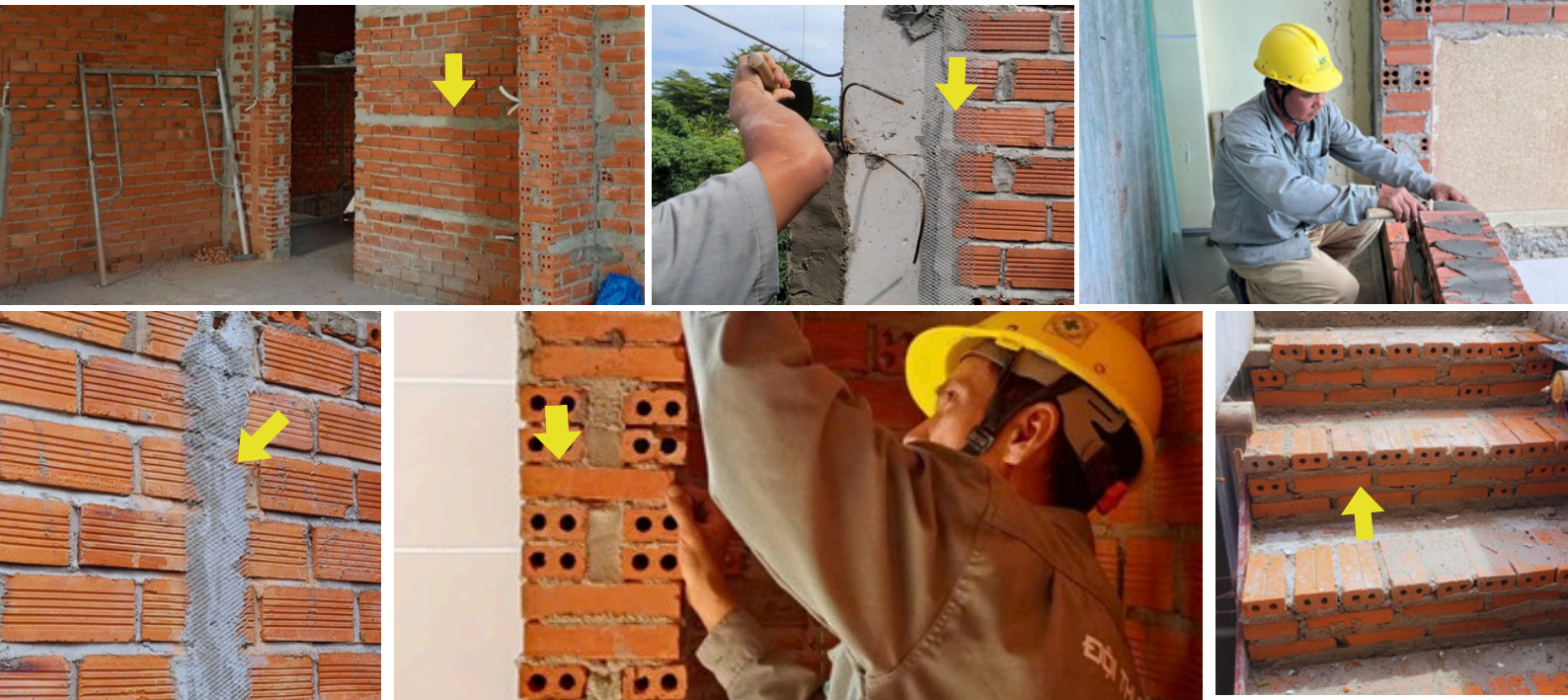
Hình ảnh: Công tác xây tường
