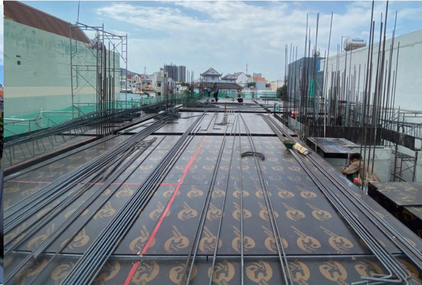
Hình ảnh: Công trình sử dụng phim lót hoặc trải bạt
