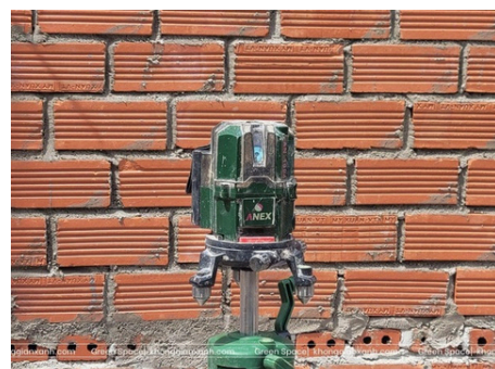
Hình ảnh: Ghém tường bằng laser
