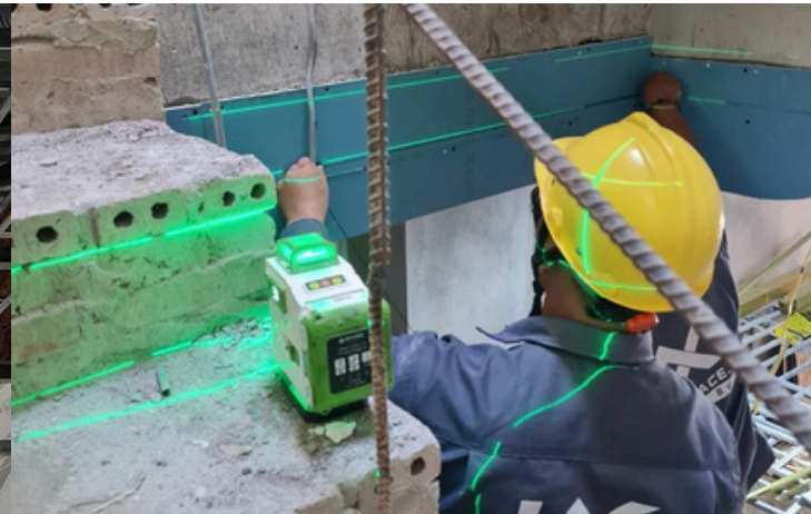
Hình ảnh: Thi công hệ khung xương bằng laser
