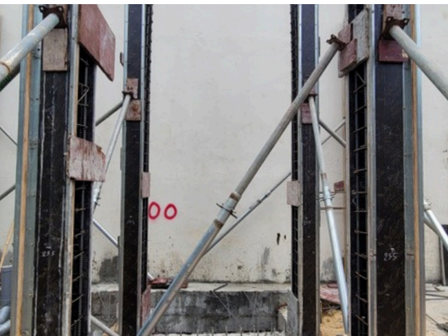
Hình ảnh: Ván khuôn được ghép cẩn thận kín, khít, đảm bảo nước & xi măng không chảy ra ngoài
