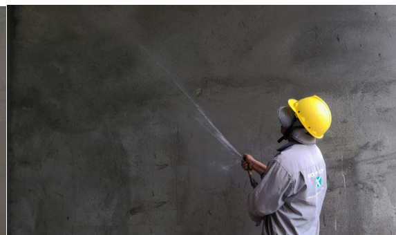
Hình ảnh: Tưới bảo dưỡng tường
