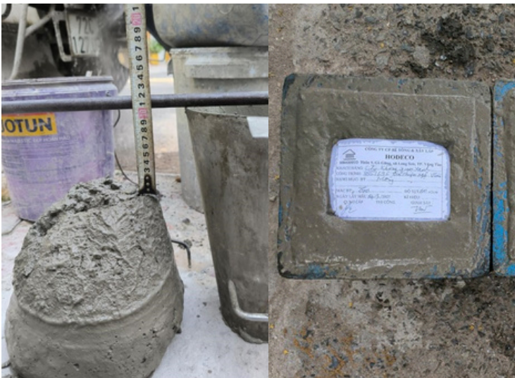
Hình ảnh: Kiểm tra cấp phối-độ sụt
