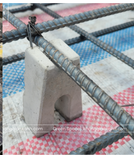
Hình ảnh: Sử dụng con kê bê tông
