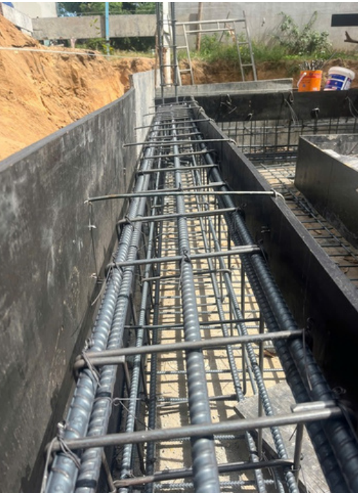
Hình ảnh: Thi công thép đà kiềng
