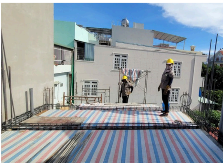
Hình ảnh: Công trình sử dụng phim lót hoặc trải bạt
