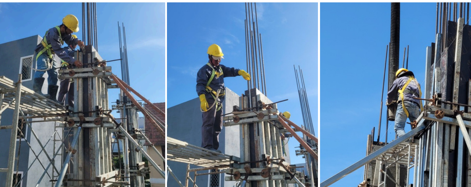
Hình ảnh: Sử dụng dây an toàn khi làm việc trên cao từ 2m trở lên.
