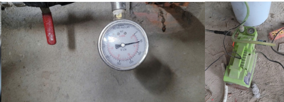
Hình ảnh: Thử áp nước trước khi hoàn thiện
