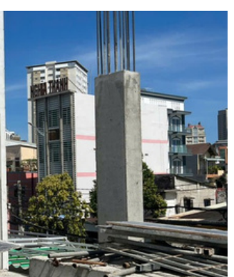
Hình ảnh: Bê tông cột sau khi tháo đảm bảo láng mịn
