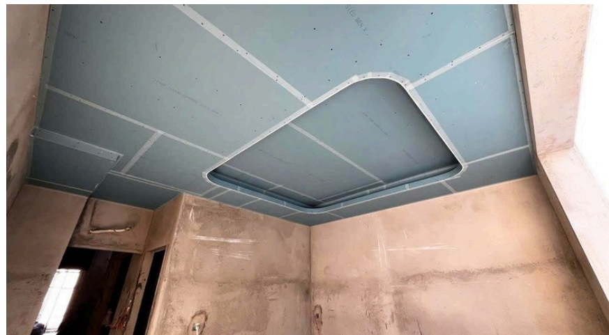
Hình ảnh: Thi công trần thạch cao bằng laser
