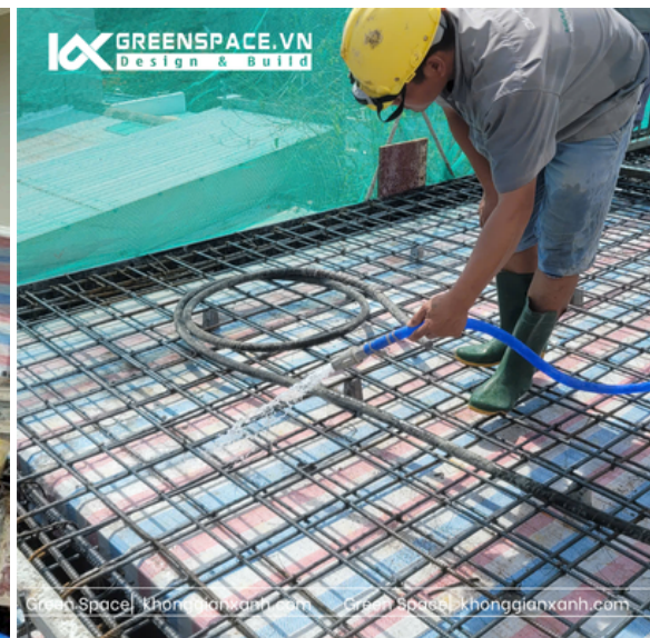
Hình ảnh: Vệ sinh - Kiểm tra sàn kĩ càng trước khi đổ bê tông
