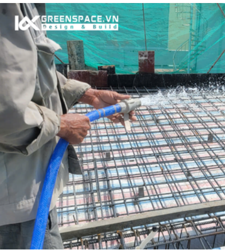
Hình ảnh: Vệ sinh - kiểm tra thép sàn trước khi đổ
