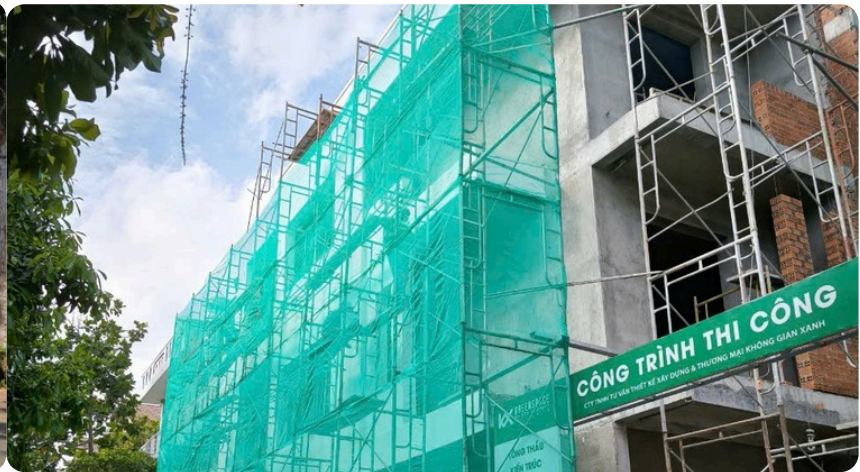
Hình ảnh: Rào công trình bằng lưới đảm bảo an toàn
