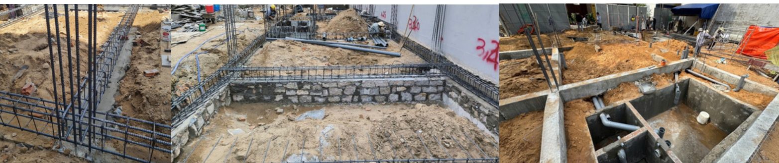
Hình ảnh: Lắp đặt cốt thép móng-định vị cột-đà kiềng-móng bó nền
